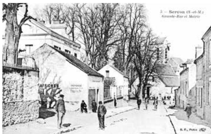
Vue latérale d'origine avec talus, annexes et clôture
